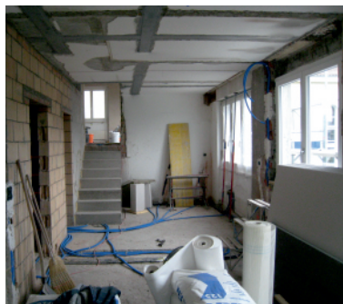
Die zukünftige Küche mit Treppenverbindung zum Obergeschoss
