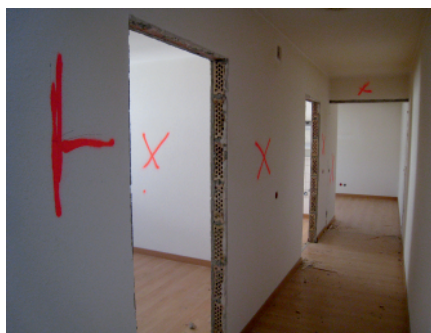
Kommt weg. Abbruch der Wände im Obergeschoss
