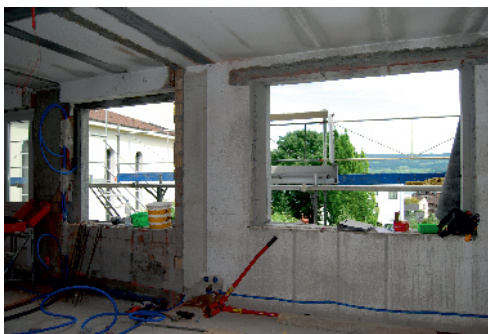
Mehr Seesicht! Neue Fenster sorgen für mehr Licht und Luft.
