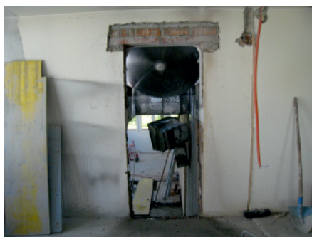
Mit dem Betonschneider werden die Wände aufgeschnitten
